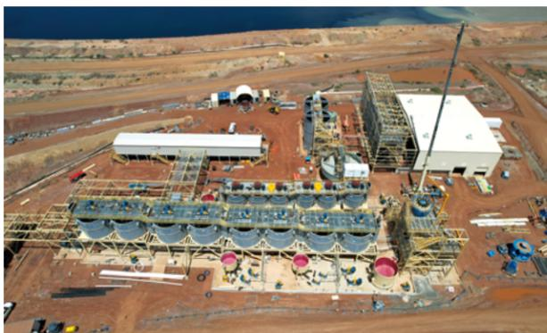
作为最大的浮选机供应商之一，北矿科技为塞尔维亚的大型铜矿设计并制作了大批量浮选机，包括在 Timok 铜金矿带矿运行的 19 台 KYF-130m<sup>3</sup> 浮选机、7 台套 XCF/KYF-30m<sup>3</sup> 充气式水平配置浮选机组；在波尔铜业 MS 矿 20000t/d 扩建项目中的 6 台 KYF-300m<sup>3</sup> 浮选机和 10 台 KYF-100m<sup>3</sup> 浮选机；以及波尔铜业 VK 矿 30000t/d 扩建项目中的 14 台 KYF-300m<sup>3</sup> 和 10 台 KYF-100m<sup>3</sup> 浮选机。此外，澳大利亚诺顿金田金矿项目也采用了北矿科技的粗选用 KYF-200m<sup>3</sup> 充气浮选机及精选用 KYF-70m<sup>3</sup> 浮选机。
