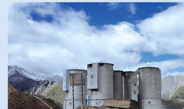
▶ 位于海拔 4830m 的甲玛铜多金属矿充填站
